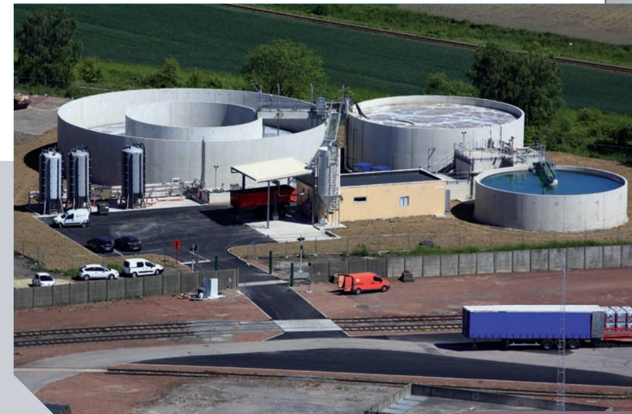
Usine - Chocques Station d'épuration
