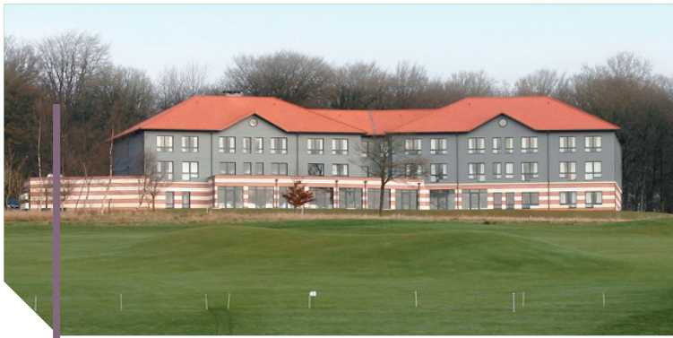
Hôtel du Golf de St Omer - Lumbres Construction d'un hôtel de 54 chambres
